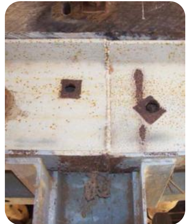
زنگ زدگی و خوردگی موضعی سطحی وجود دارد اما کاهش سطح مقطع رخ نداده است.
