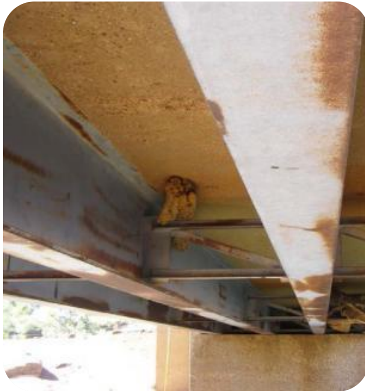
خوردگی جزئی در اتصالات، خوردگی سطحی موضعی
