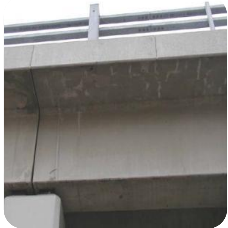
ترکهای مویی با فاصله کم همراه با شوره زدگی بر روی سطح وجود دارند.
