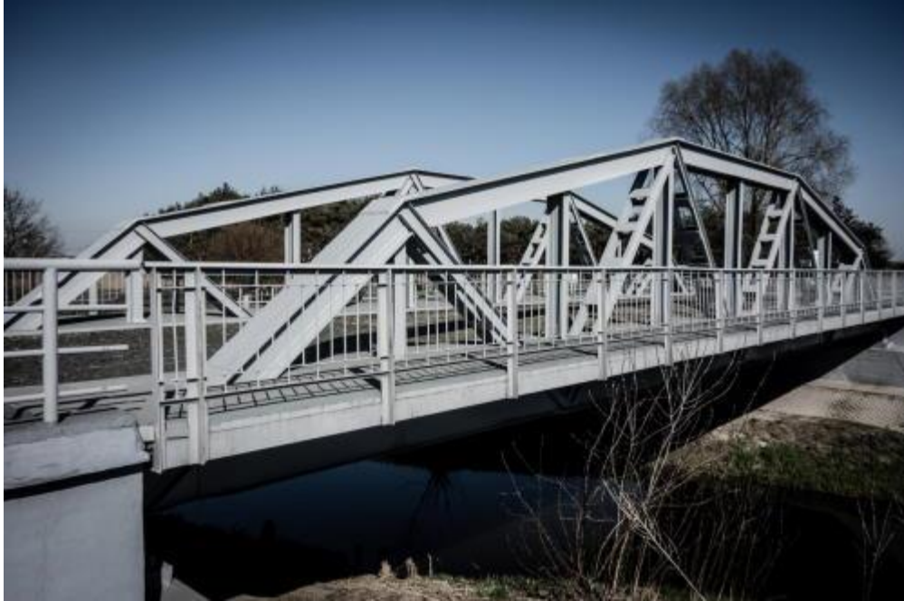
پل مارزایس در کشور لهستان (اولین پل طراحی شده بر اساس جوشکاری)
