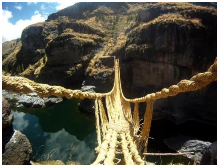
پل معلق اینکا در کشور پرو، نمونه‌ای از یک معلق ساخته شده از طناب
