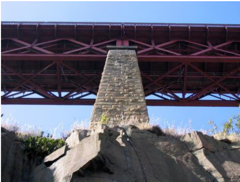
پایه میانی در یک پل مخصوص راه‌آهن
